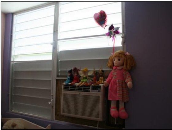
Fig. 2.12. Window A/C Unit
