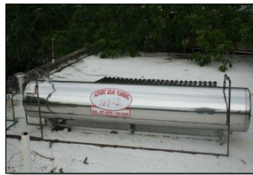
Fig. 2.24. Solar HW Heater
